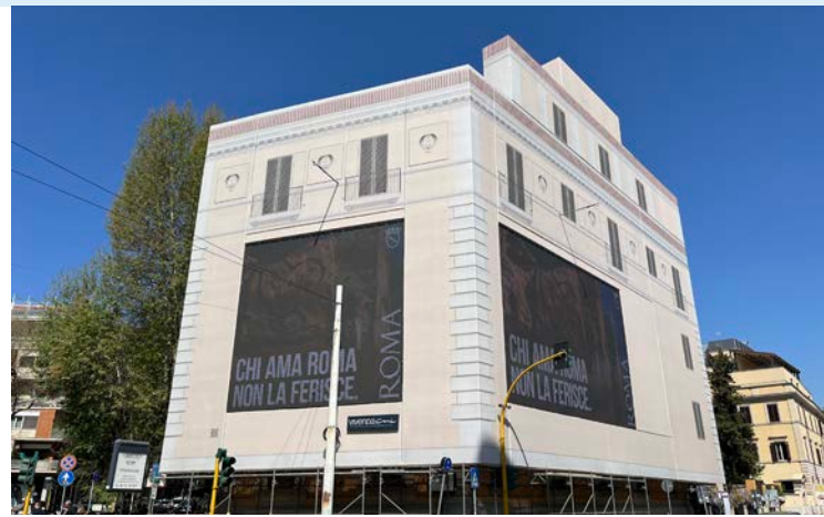
大樓修繕加裝的帷幕牆
